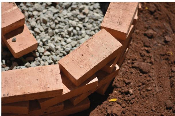
*O detalhe da camada de brita no fundo da mandala, para a drenagem da água.*
